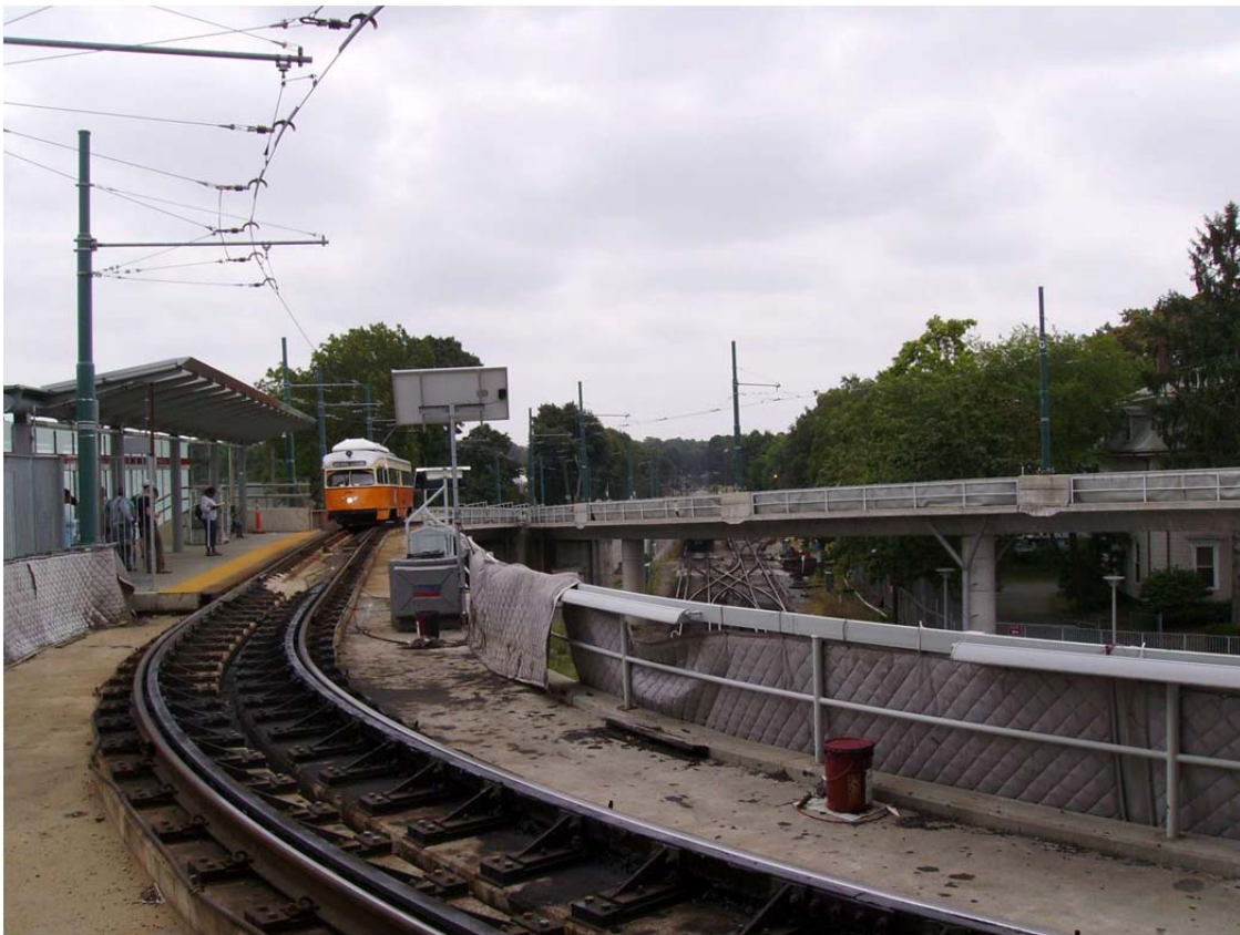
Foto 10 - Il capolinea attuale della Ashmont-Mattapan line si trova sopra all' asta di manovra della linea metropolitana rossa ( visibile al centro ), ed è costituito da un anello sopraelevato
